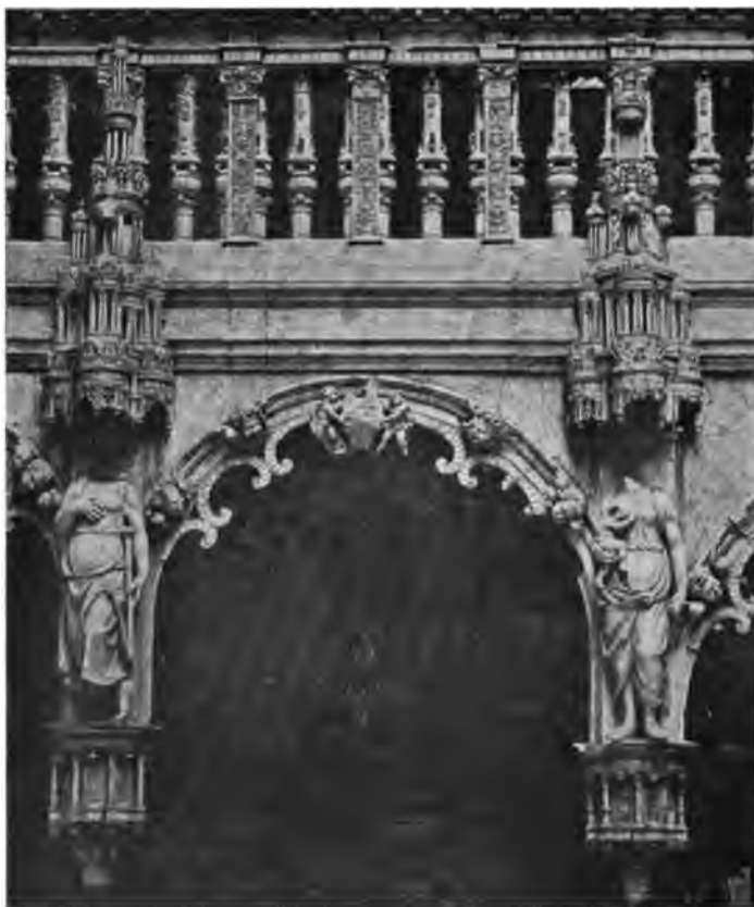
Fig. 117. — Appui du Jubé de la cathédrale de Limoges. Alternance de pilastres et de balustres dans la balustrade.
